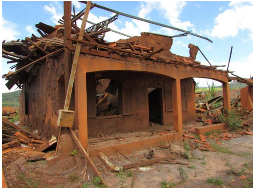
Figura 1. Destruição do distrito de Bento Rodrigues (fonte: os autores).
