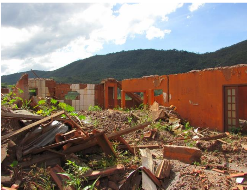
Figura 3. Destruição do distrito de Bento Rodrigues (fonte: os autores).
