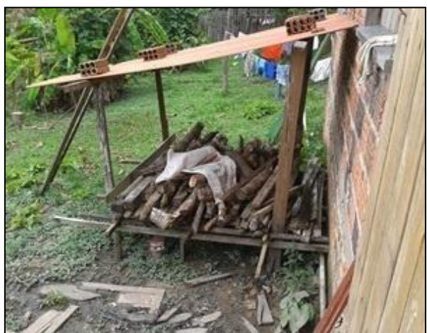
Figura 15. Material armazenado de modo organizado e protegido. Fonte: Registro fotográfico de Sandra Bezerra, 2014.
