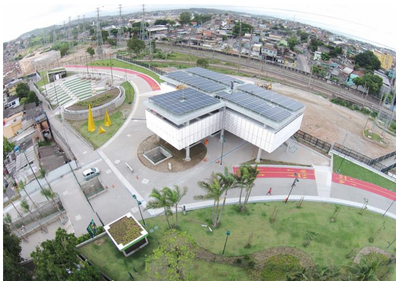
Figura 8: Painéis fotovoltaicos no Prédio Multiuso - Parque Madureira. Fonte: http://ciclovivo.com.br/noticia/edificio-em-parque-no-rioganha-264-paineis-solares-fotovoltaicos/ . Acesso: setembro/2017.
