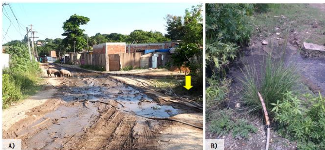
Figura 9 - a) Mangueiras direcionando a água da rede geral aos domicílios. Destaca-se que não houve chuva na semana da captura da foto, logo o estado da via de acesso se dá pelas mangueiras de água e pelo constante fluxo de caminhões de lixo. b) Mangueira de água sobre vala de esgoto.
