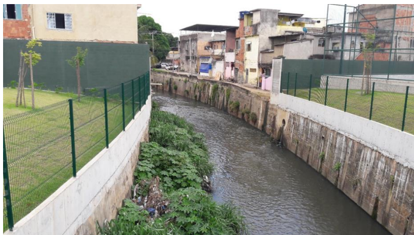
Figura 9: Córrego em trecho que atravessa o Parque recebendo esgoto das residências (2017).
