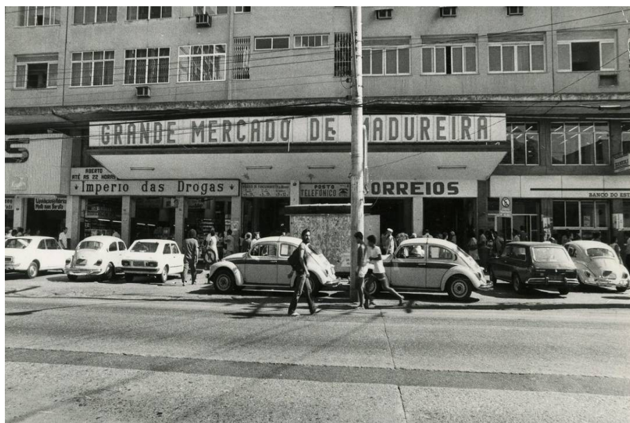
Figura 1 - Registro da entrada do Mercado na década de 1970.
