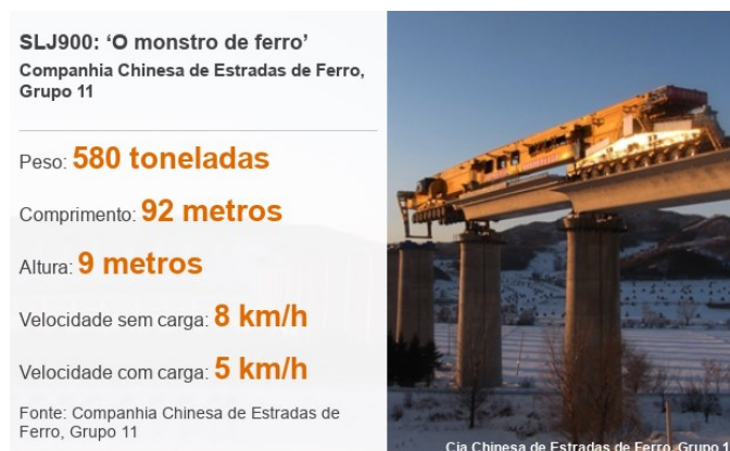
Figura 2: SLJ900, máquina que constrói pontes ferroviárias, conhecida como Monstro de Ferro. Fonte: BBC Brasil
