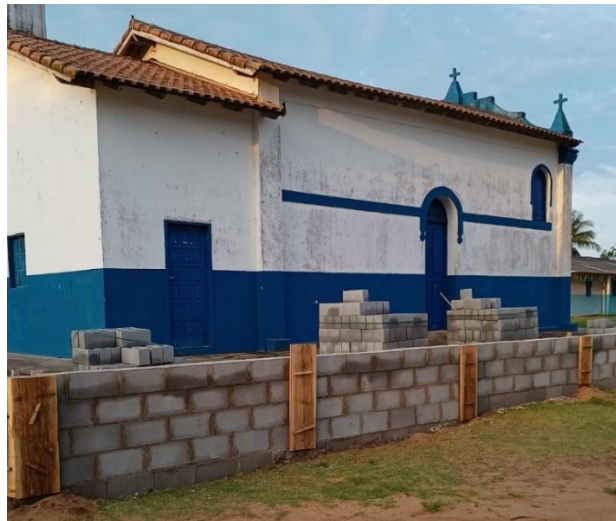
Figura 15: Construção do muro entorno da Igreja de São Benedito Fonte: Trabalho de campo outubro de 2023
