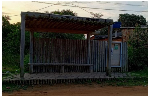
Figura 16: Ponto de ônibus construído como medida compensatória Fonte: Trabalho de campo, maio de 2022
