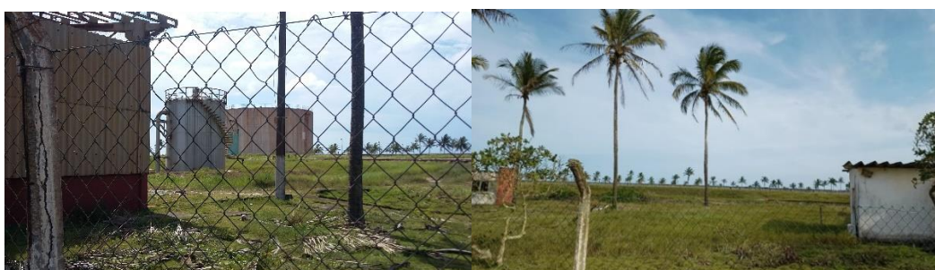
Figura 12: Área do Terminal de Regência (Tereg), em meio a Reserva Biológica de Comboios: antes de ser desmontado em 2018 e depois de ser desmontado em 2022
